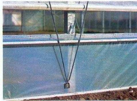
Seitenlüftung mit elastischen Kabeln
