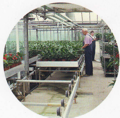
Stationäre Transportbahn mit oder ohne pneumatische Hubelemente
